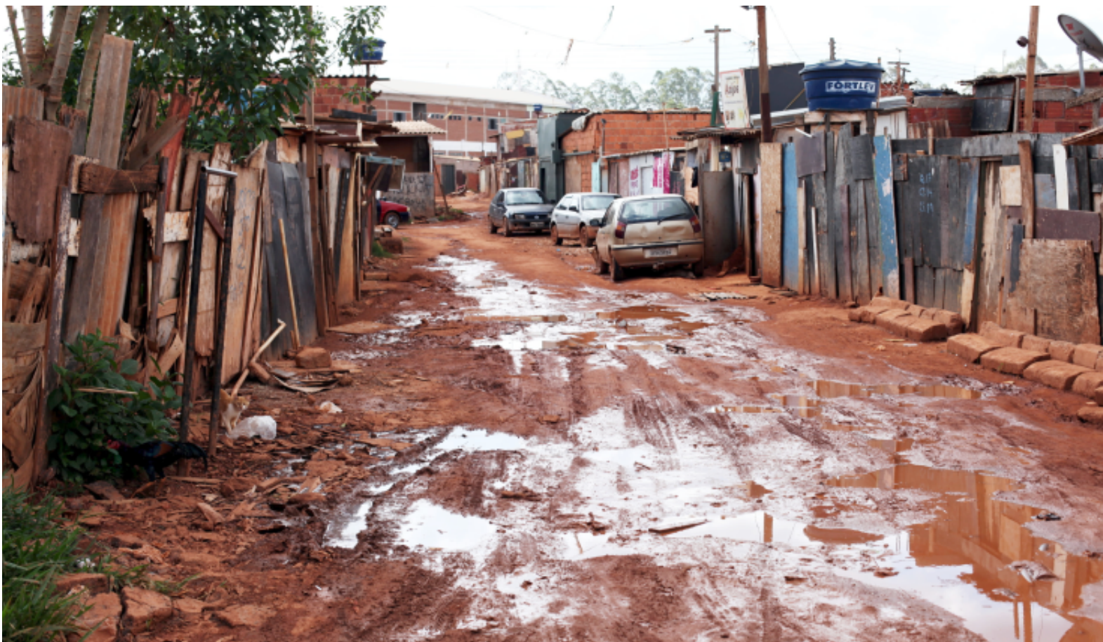
Ruas de terra e lama na Santa Luzia/ Estrutural.
