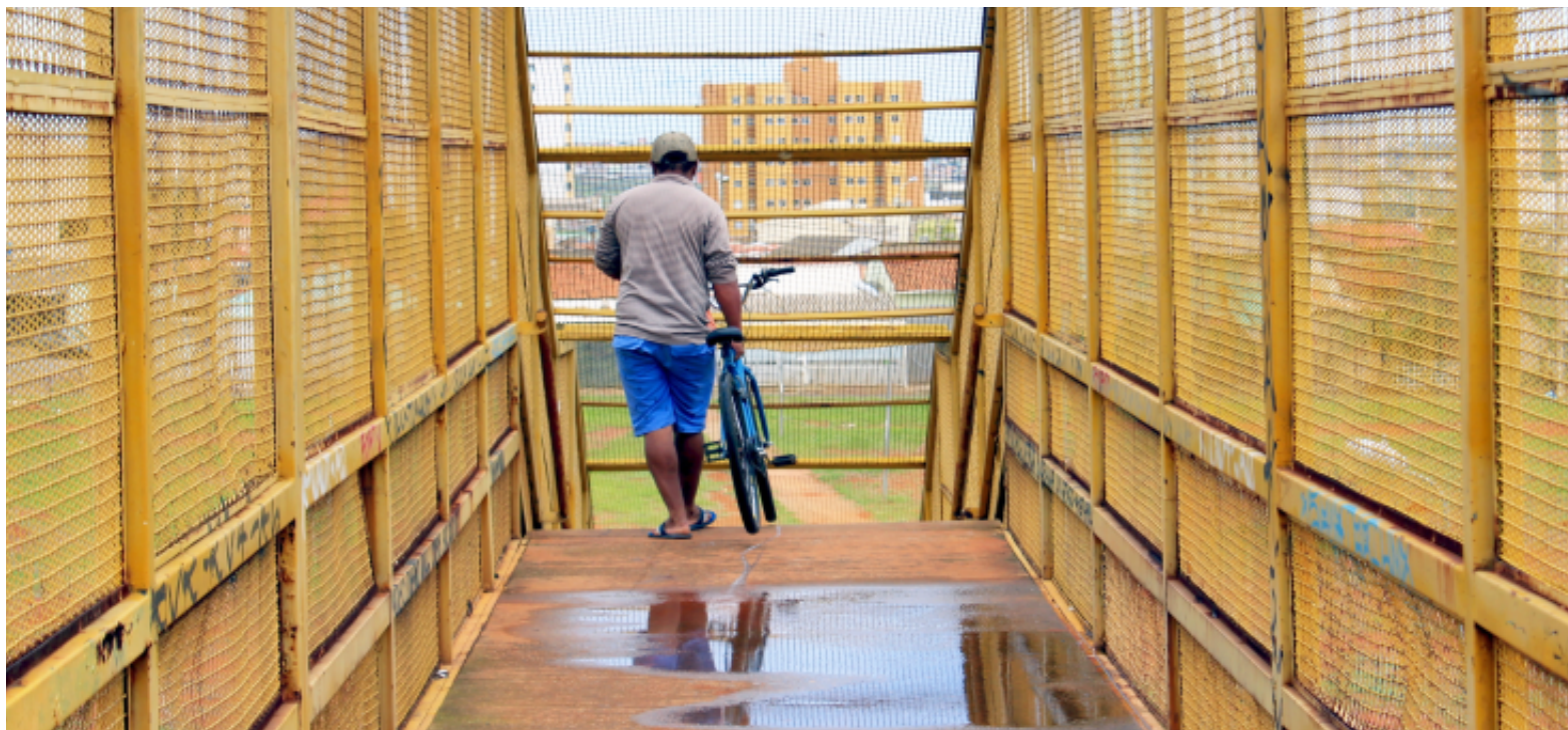
Passarela do Metrô na Samambaia - falta de acessibilidade.
